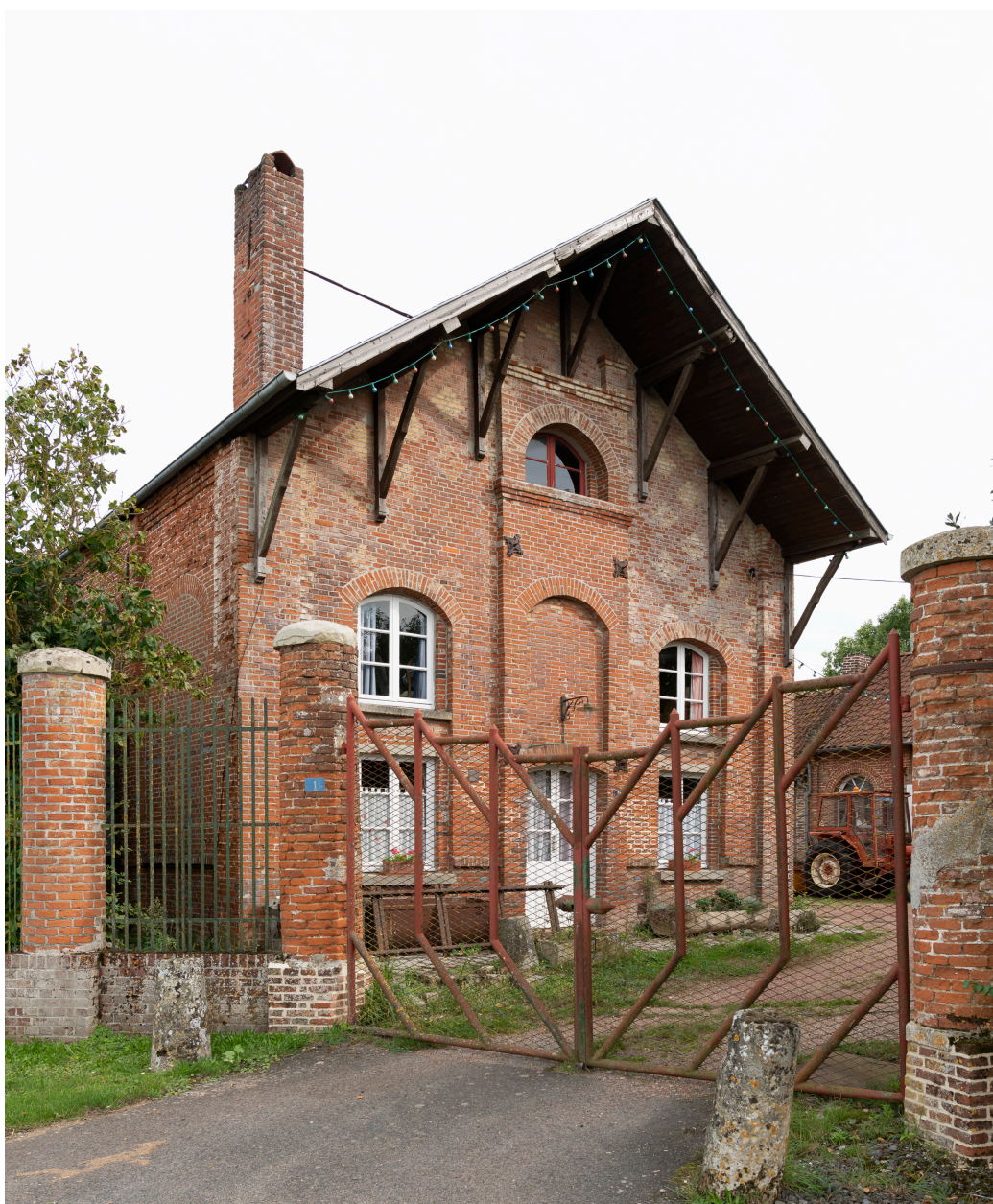
Entrée de l'ancien atelier depuis le nord-ouest.
