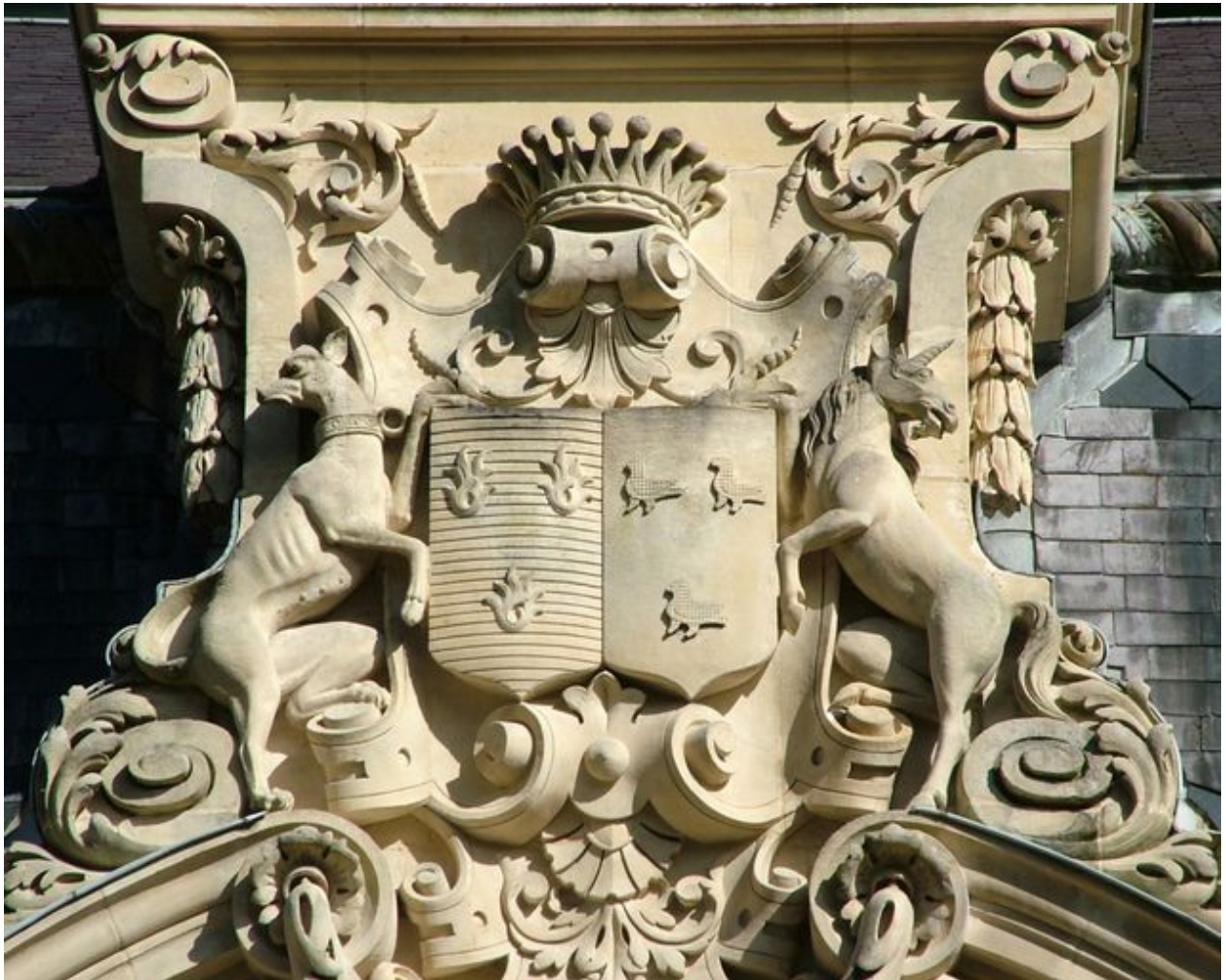
Détail des armoiries d'alliance des familles de Brandt et de Rosny, sculptées sur l'édicule couronnant la travée centrale de la façade postérieure.
