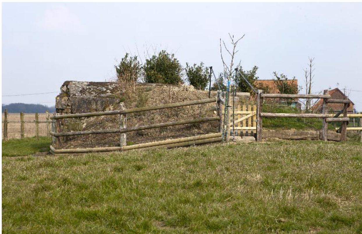
Vue latérale, vers l'ouest
