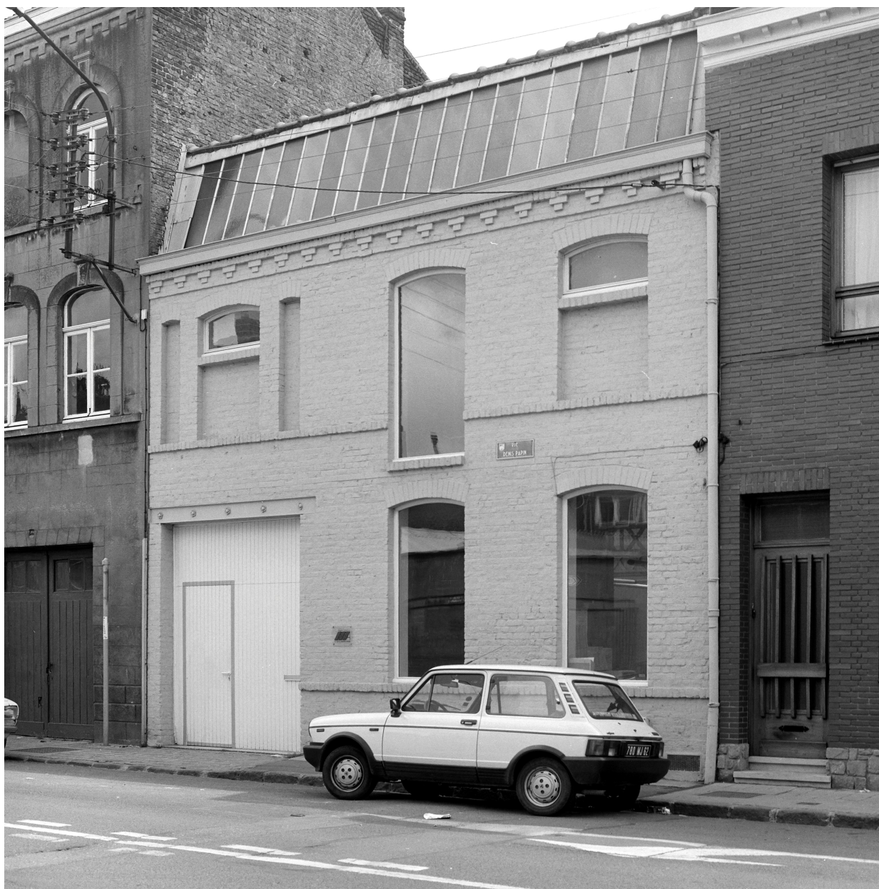
Atelier de fabrication. Élévation rue Denis-Papin.
