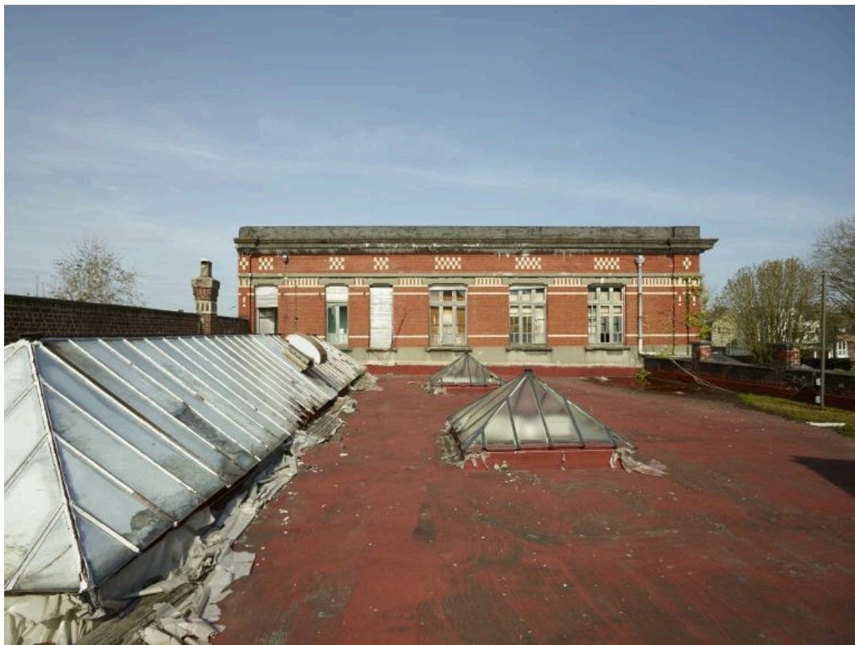
Bureaux. Couvrement. Vue prise vers l'est.
