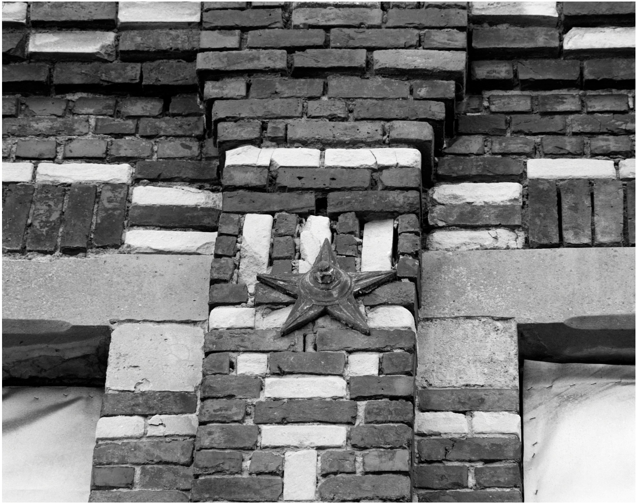
Atelier de fabrication, façade nord-ouest. Fer d'ancrage et décor de brique.
