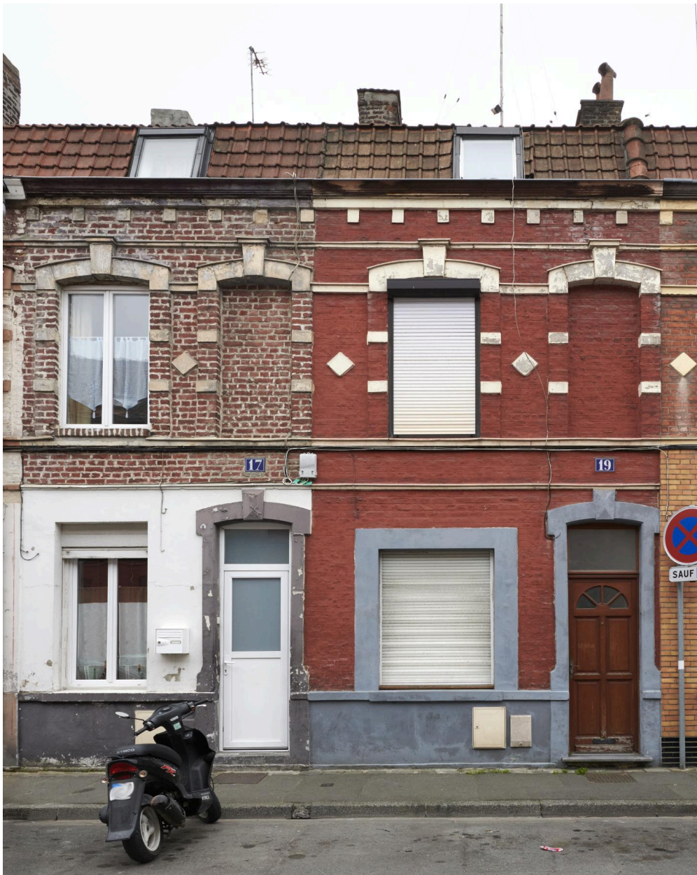
Vue générale des n°17-18 rue du Marquisat, briques et losanges sur la longueur des façades.
