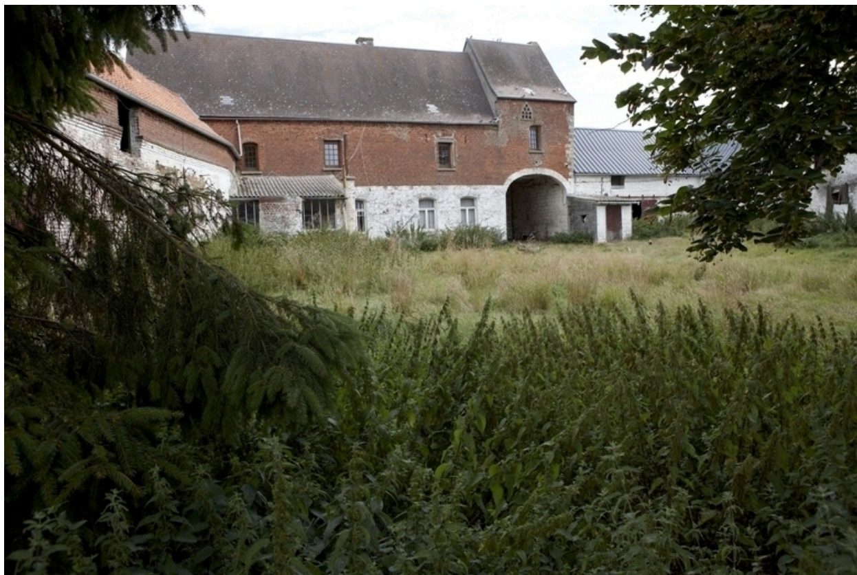
Vue de la ferme depuis la cour.
