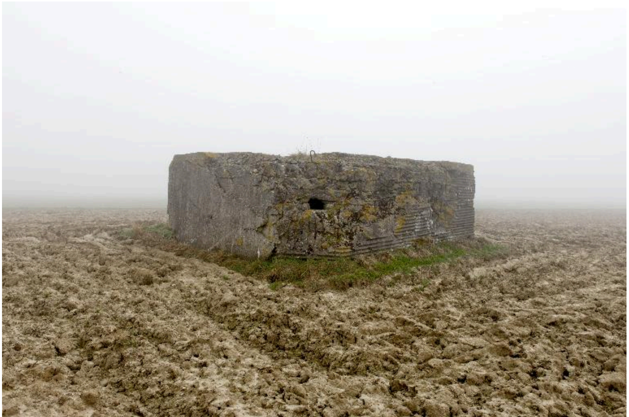
Vue de trois-quarts vers le nord-est
