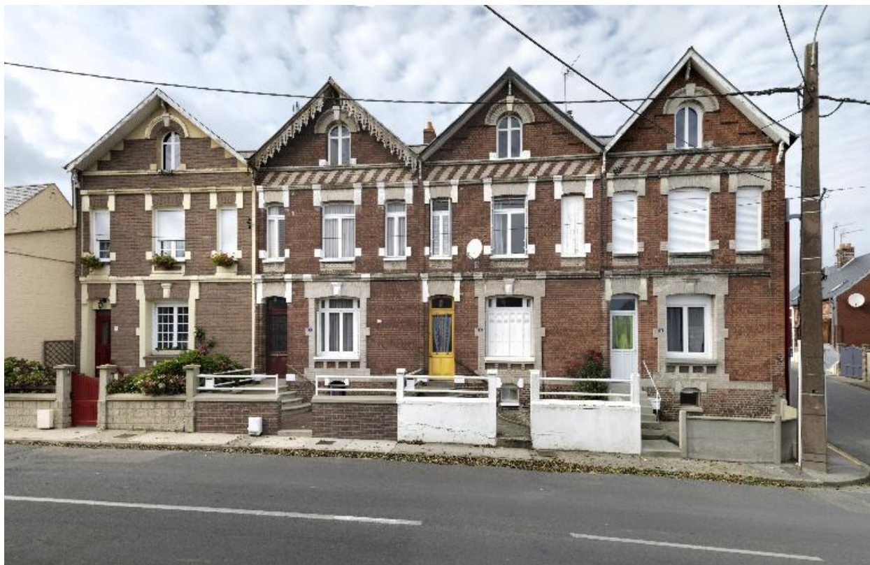
Vue générale depuis la rue du Bas
