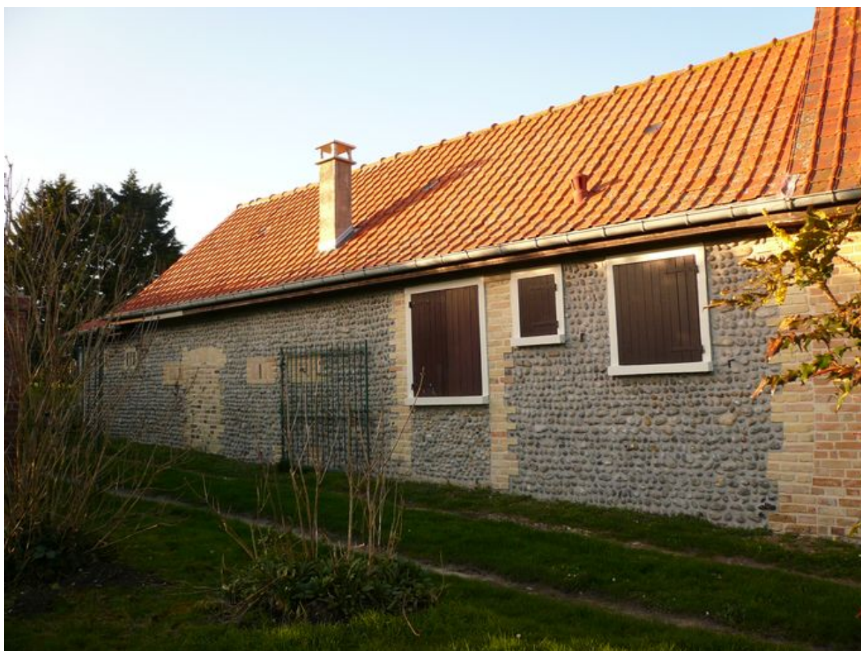
Vue détaillée de la partie écurie.
