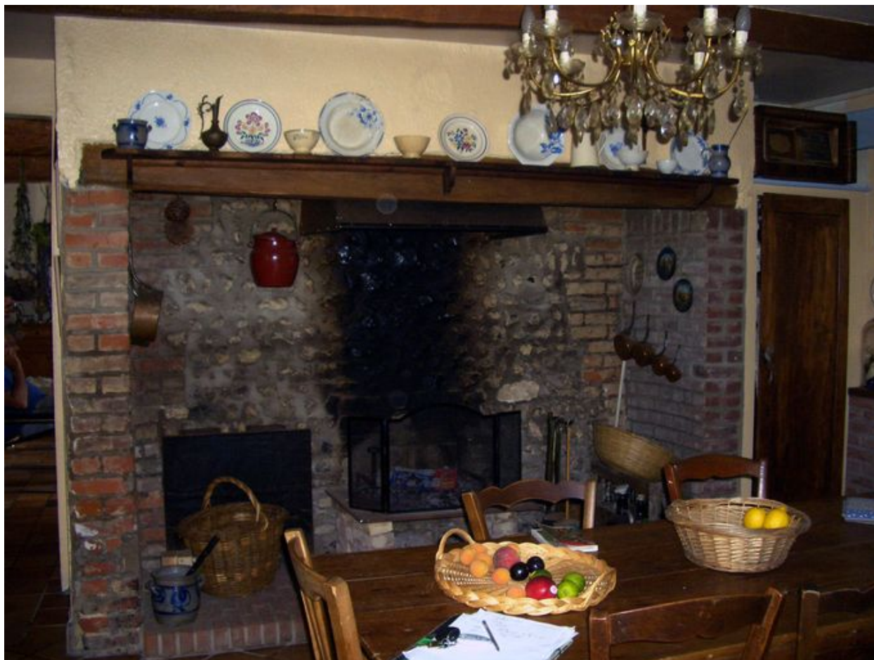
Exemple de cheminée composée d'un blocage de silex avec jambages en brique.
