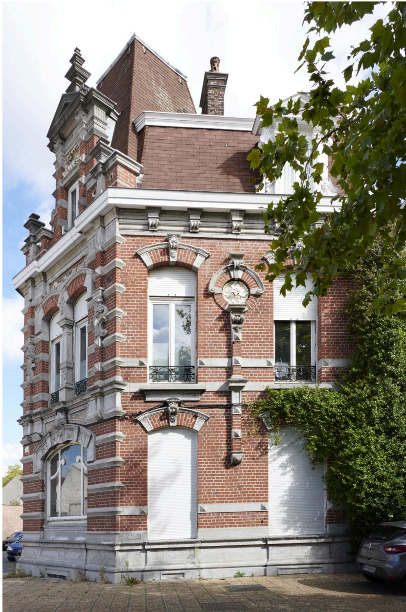
Vue générale : angle et façade place Édouard-Roussel.
