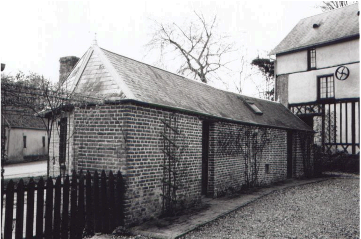
Façade sur cour des dépendances longeant la rivière.
