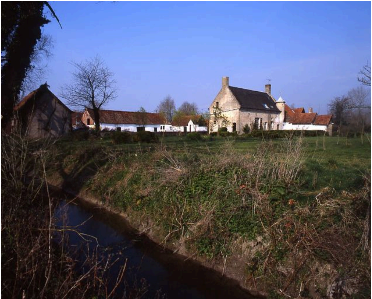
Vue générale depuis l'est.
