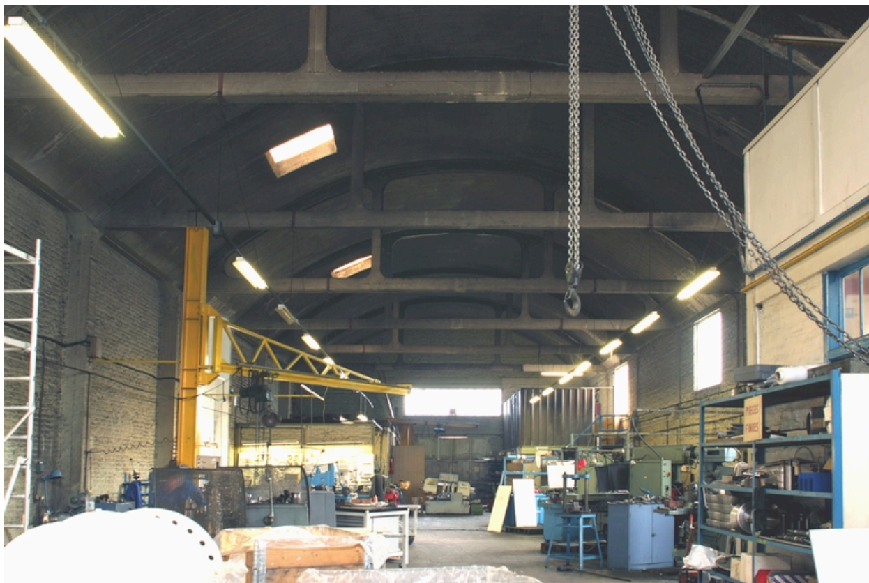
Vue intérieure de l'atelier.
