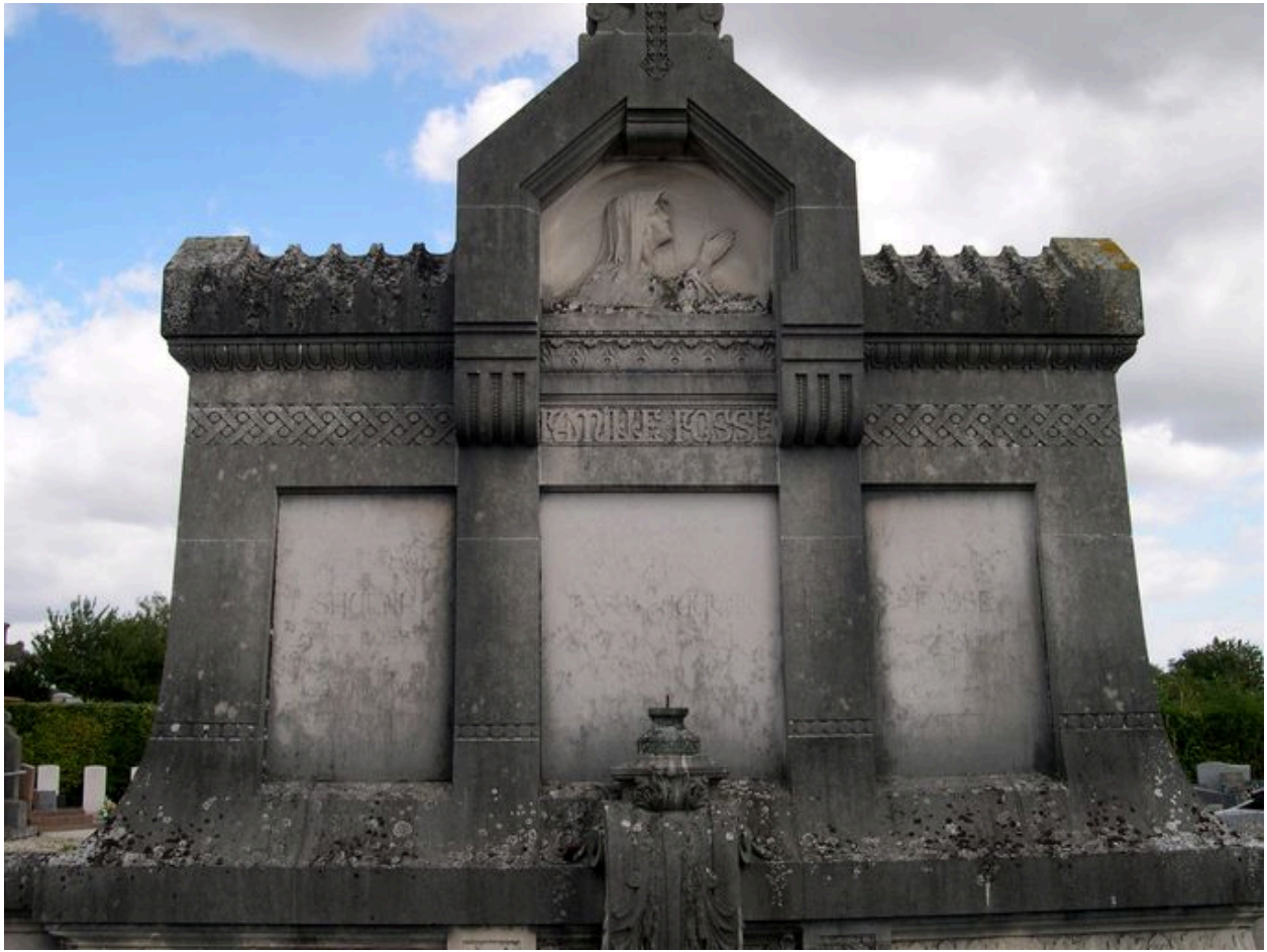
Vue de la partie supérieure du monument.
