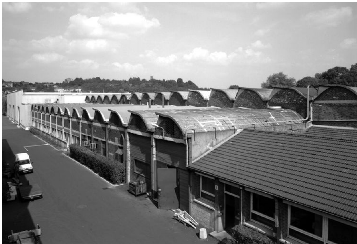
Vue de la double rangée des ateliers couverts des sheds.
