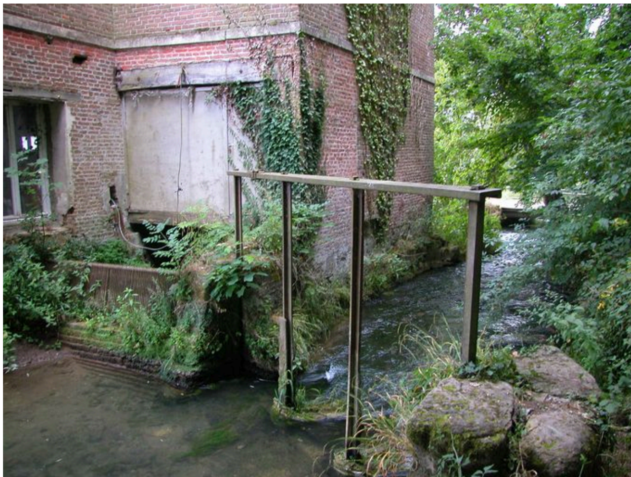
La coulerie et le vannage de décharge.
