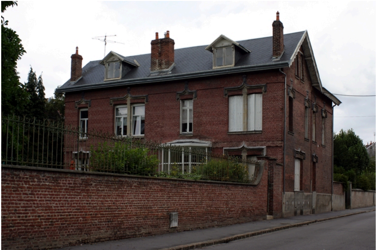
Façade antérieure du logement patronal.
