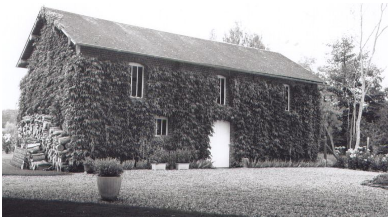
Ecurie et entrepôt de la minoterie.
