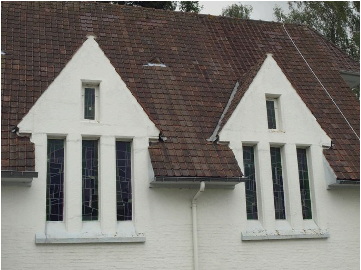
Chapelle : détail des fenêtres latérales
