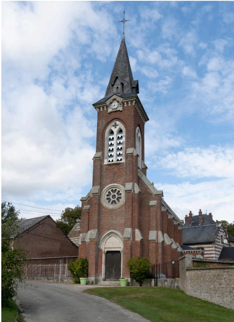
Vue générale depuis le sud.
