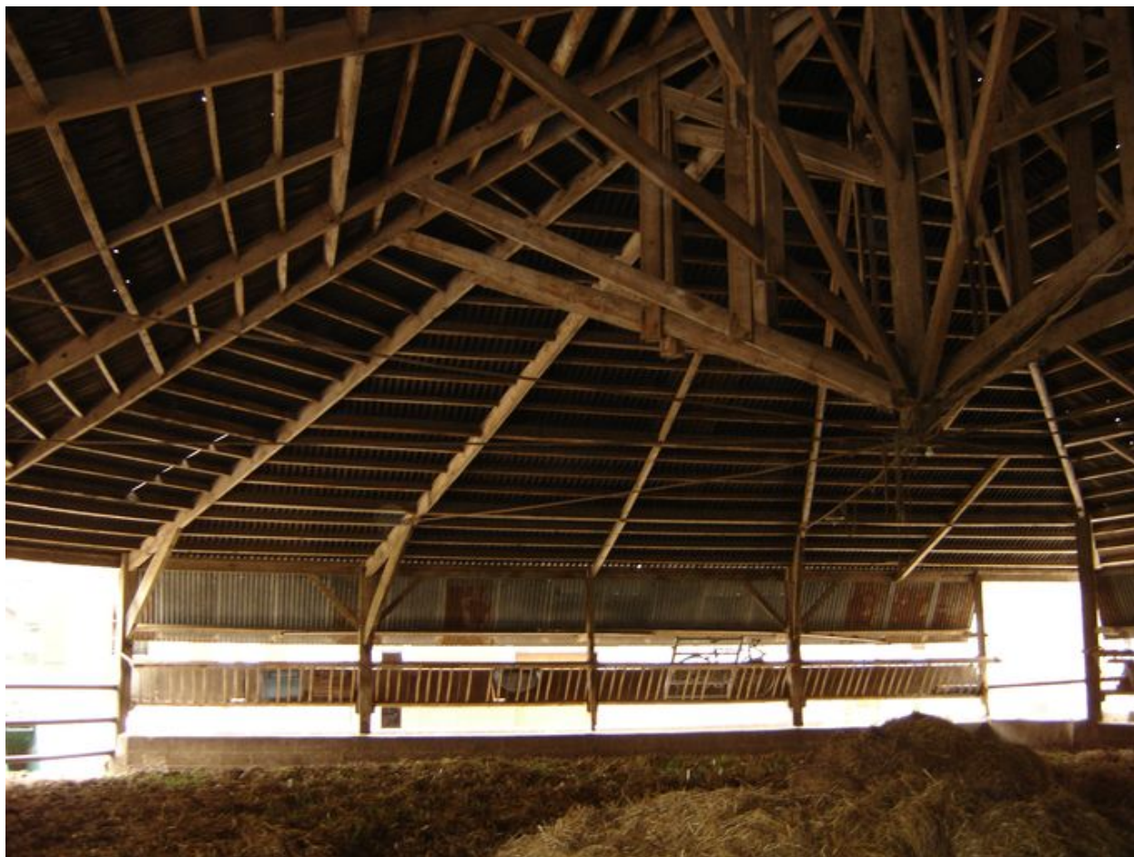
Vue intérieure avec détail de la charpente rayonnante et des auges.
