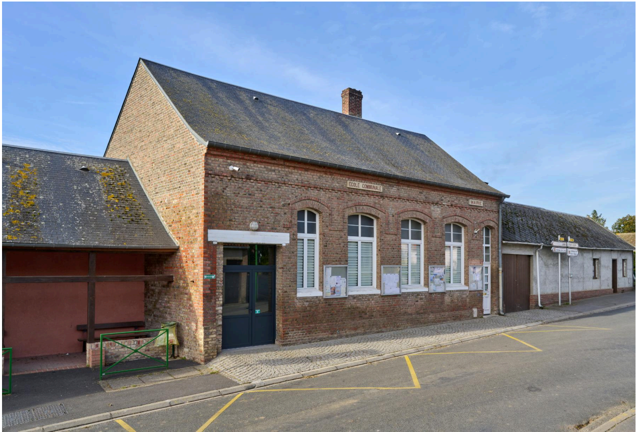
Mairie, vue prise depuis le nord-est.
