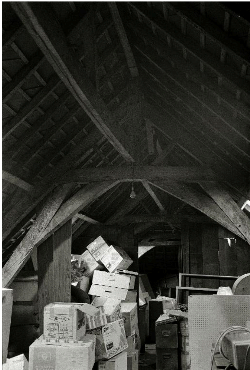
Vue intérieure des combles, en 1990.
