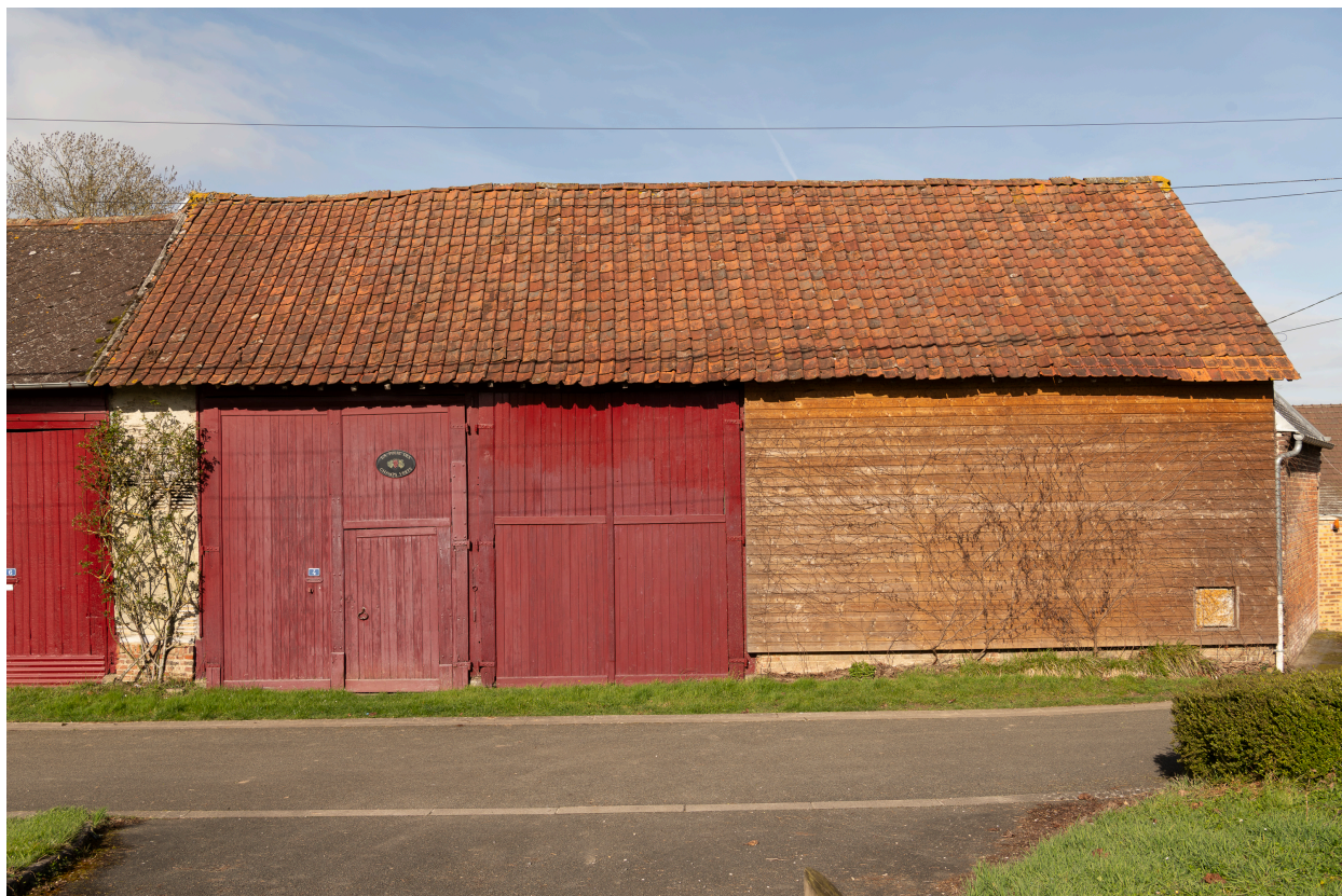
Ancienne grange sur rue, n°4 de la rue de l'Église, vue depuis le sud.
