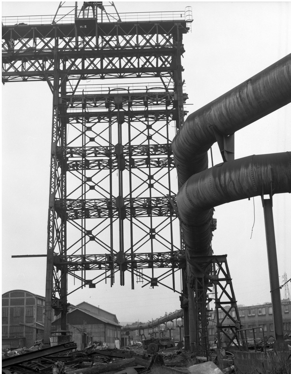
Portique : vue générale.
