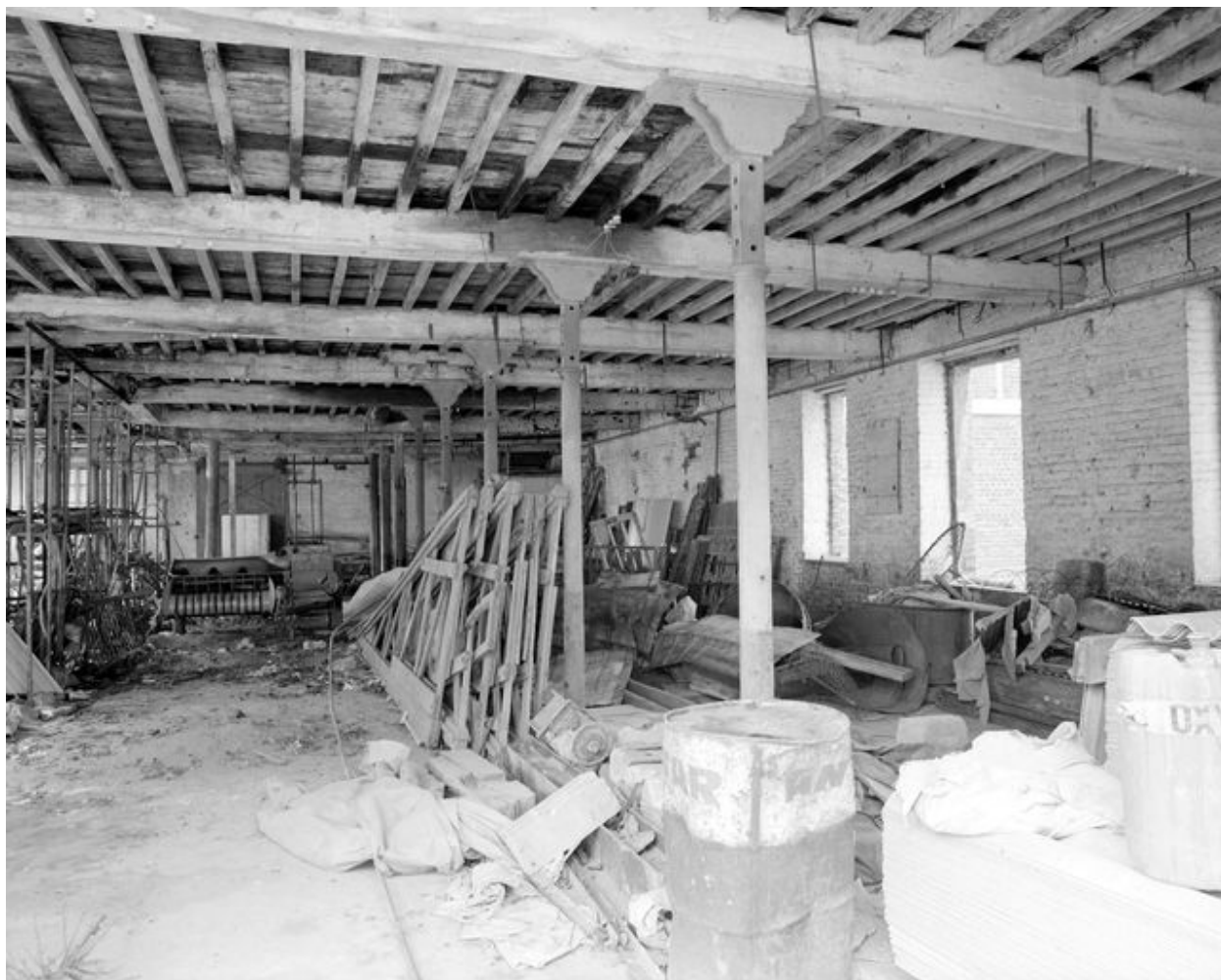
Ateliers de fabrication, rez-de-chaussée, vue intérieure.
