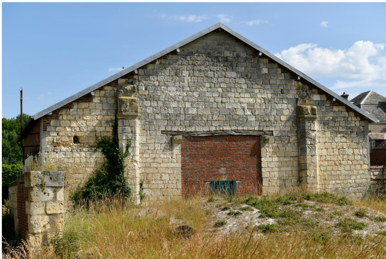
Mur intérieur du pignon nord.
