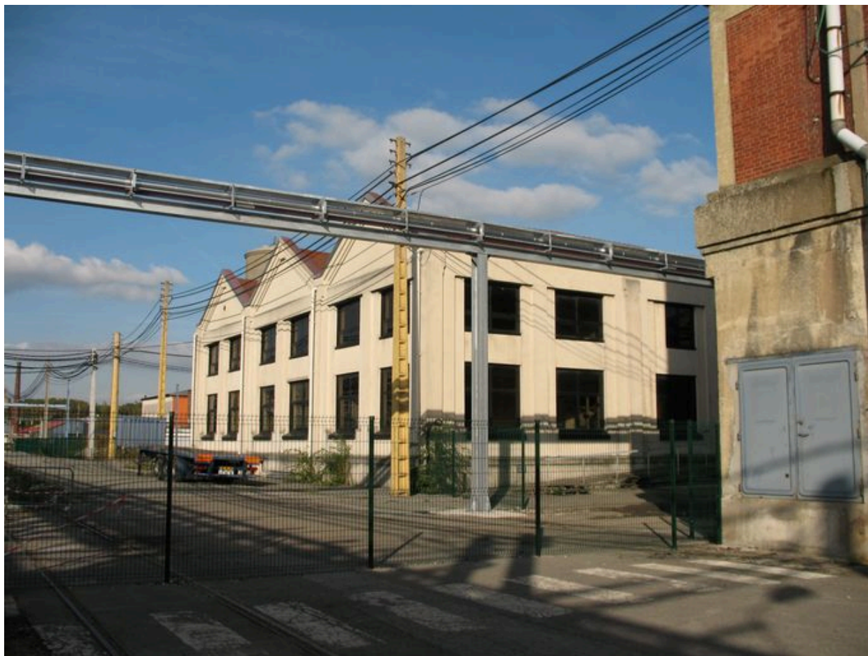
Bâtiment numéro 2 abritant les bureaux construit à la fin des années 1910.
