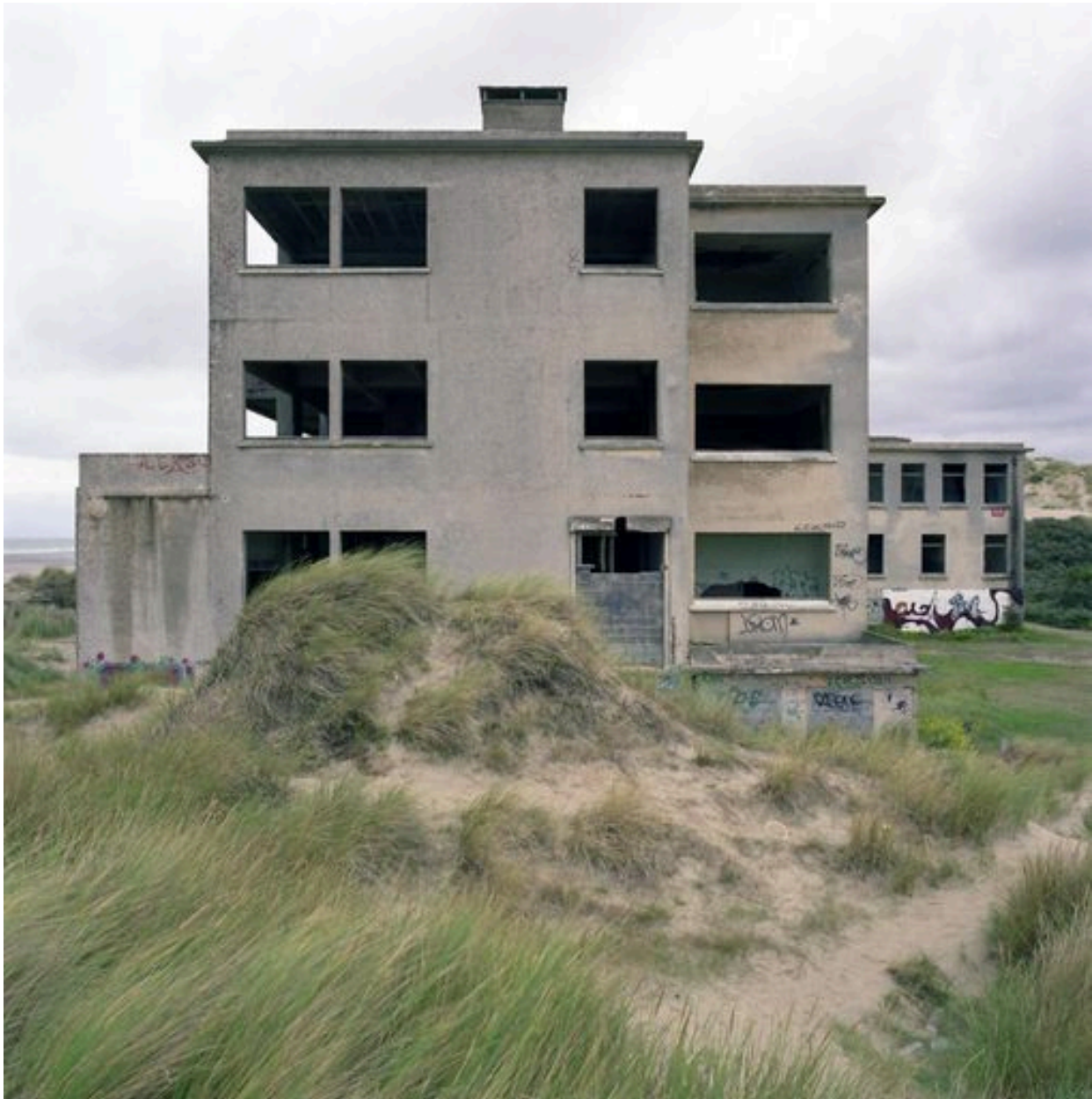
Elévation latérale sud, vue générale.
