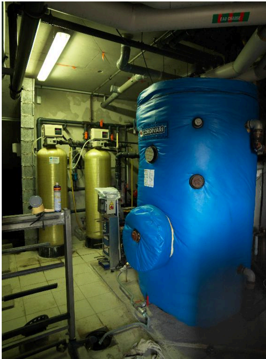
Local technique : ballon d'eau chaude.
