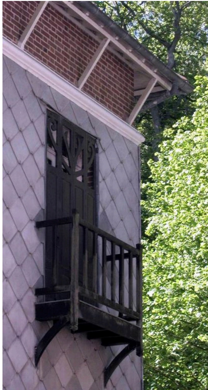
Détail d'un contrevent, élévation latérale droite.
