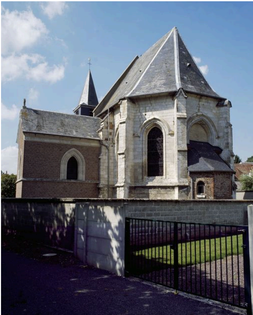
Fransu, église paroissiale Saint-Ferréol, 2e moitié du 16e siècle (chevet) et 18e siècle (façade et clocher).
