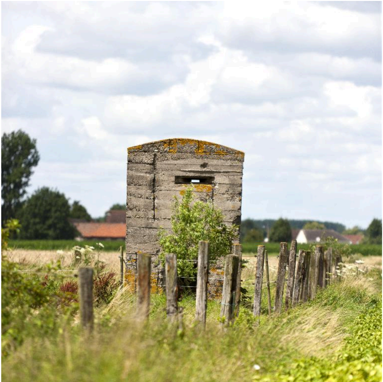
Vue générale vers le nord-ouest
