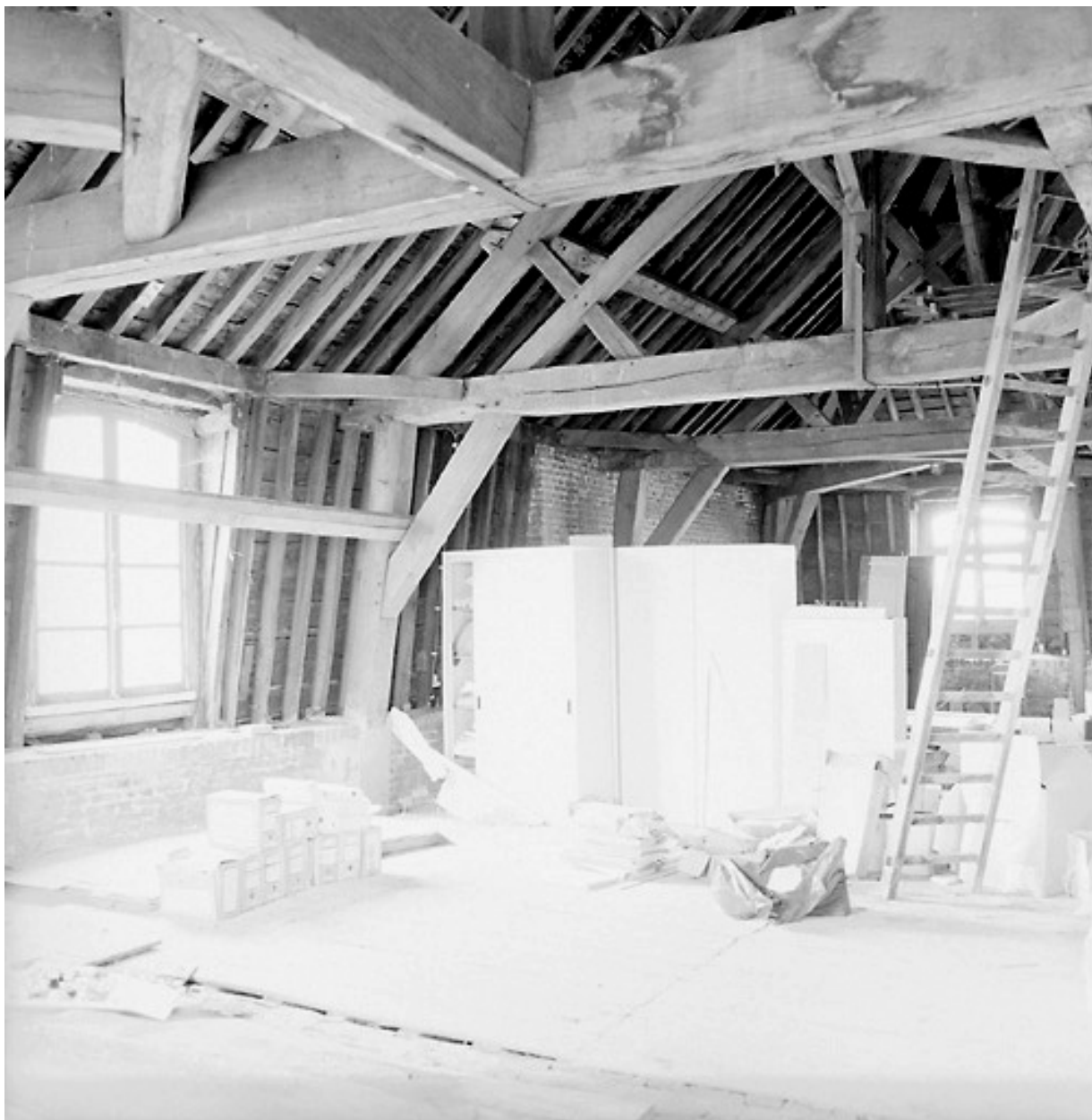
Intérieur, étage de comble : grenier, vue générale.
