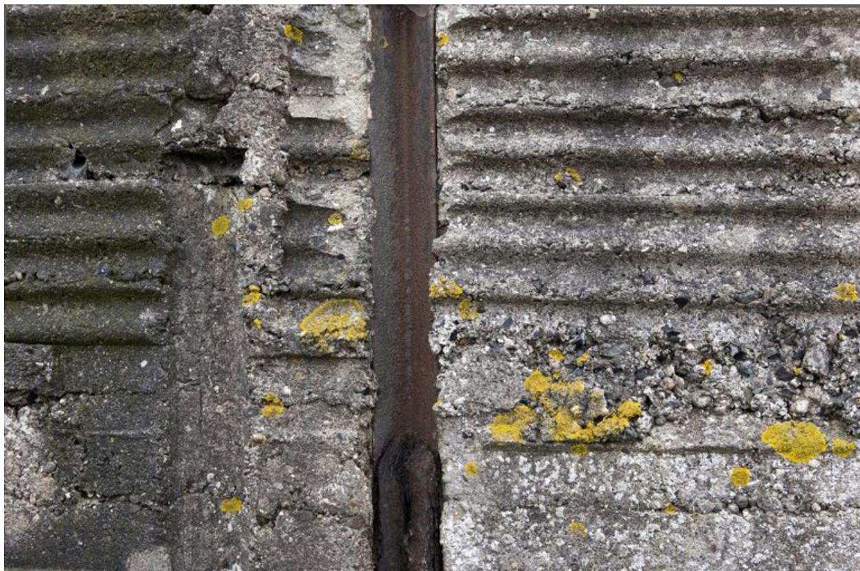
Elévation nord, détail de traces de coffrage
