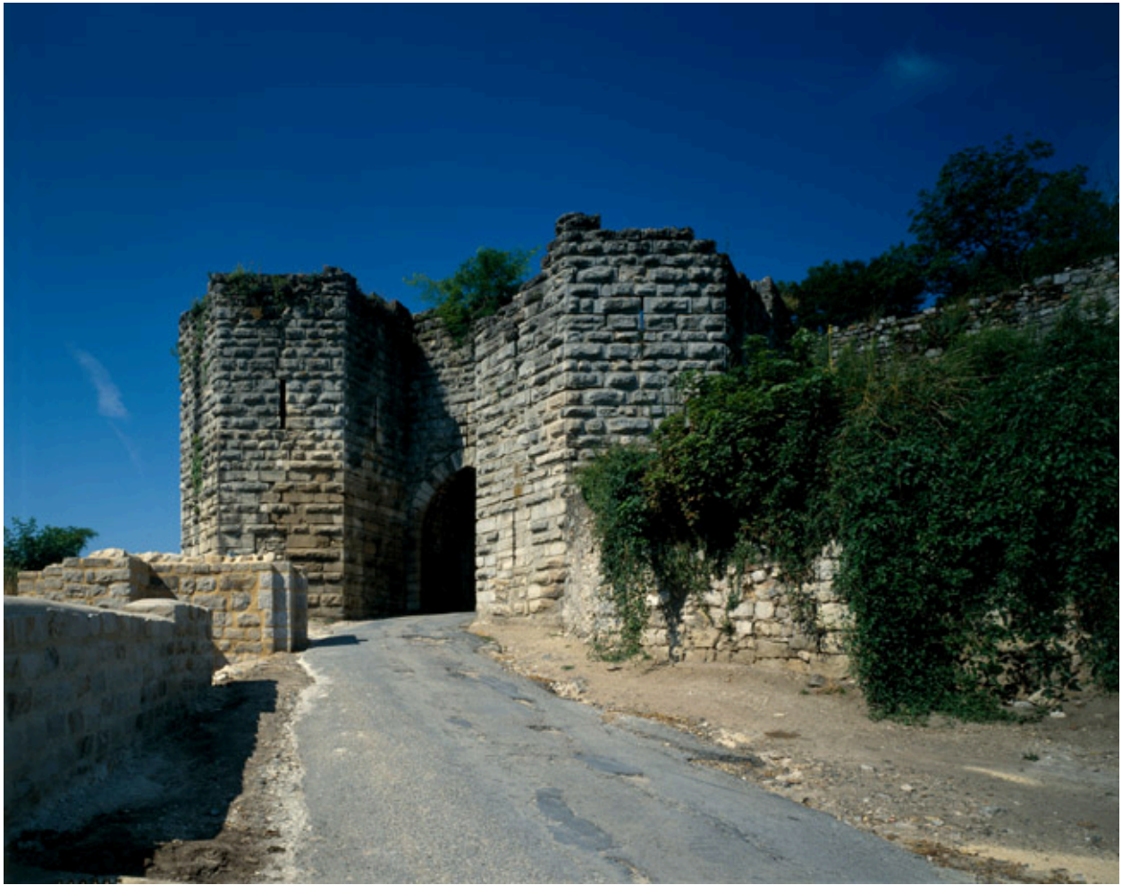
La porte Saint-Jean, depuis le chemin d'accès.
