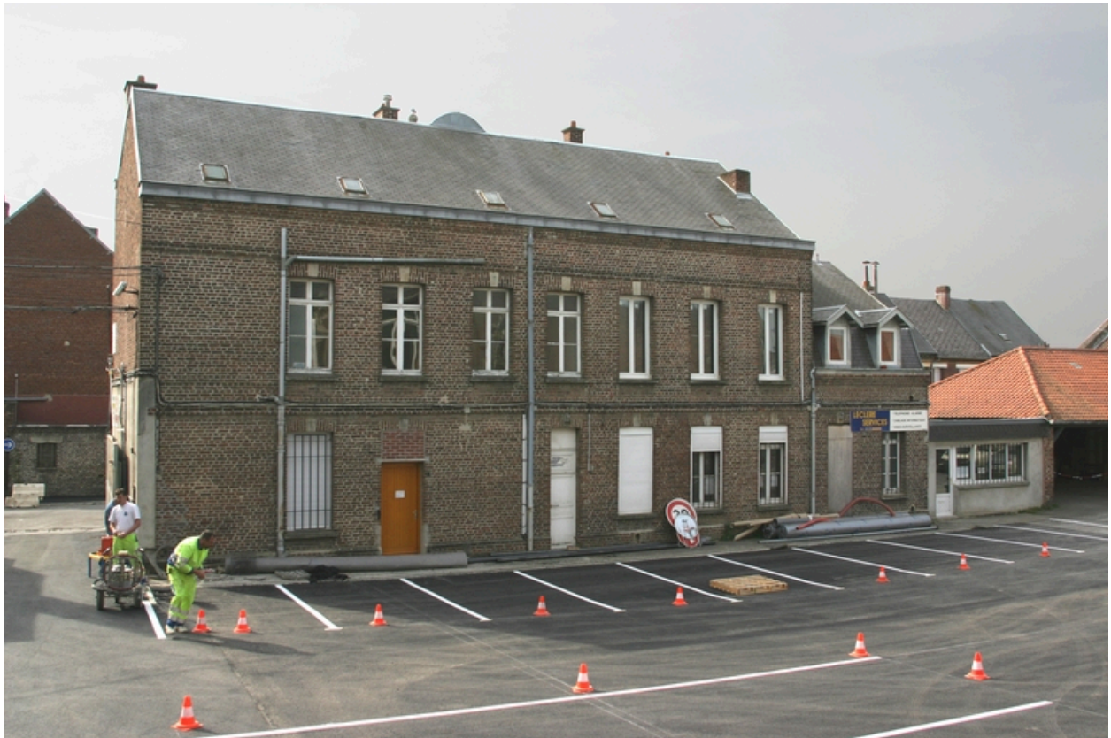
Façade postérieure du logement de directeur et des premiers bureaux.
