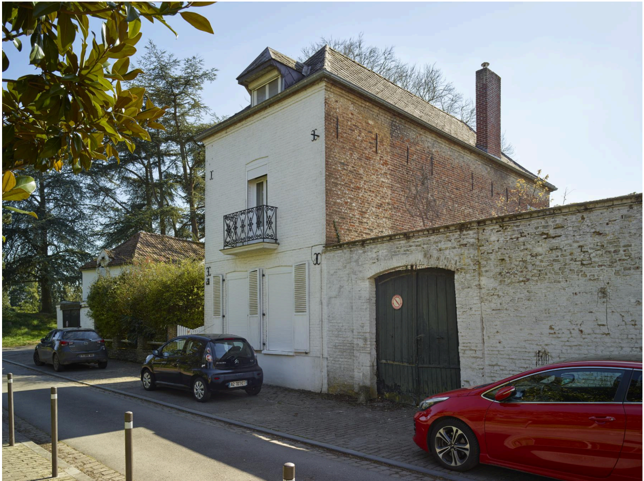
Maison : vue générale de détail de la façade sur la place du Casse-Tête.
