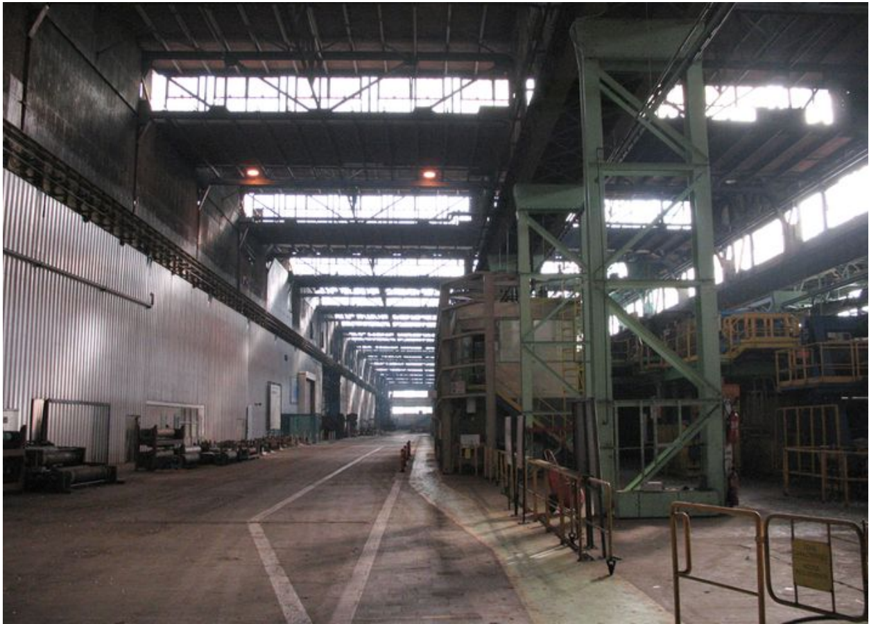
Ligne de décapage (à l'arrêt).
