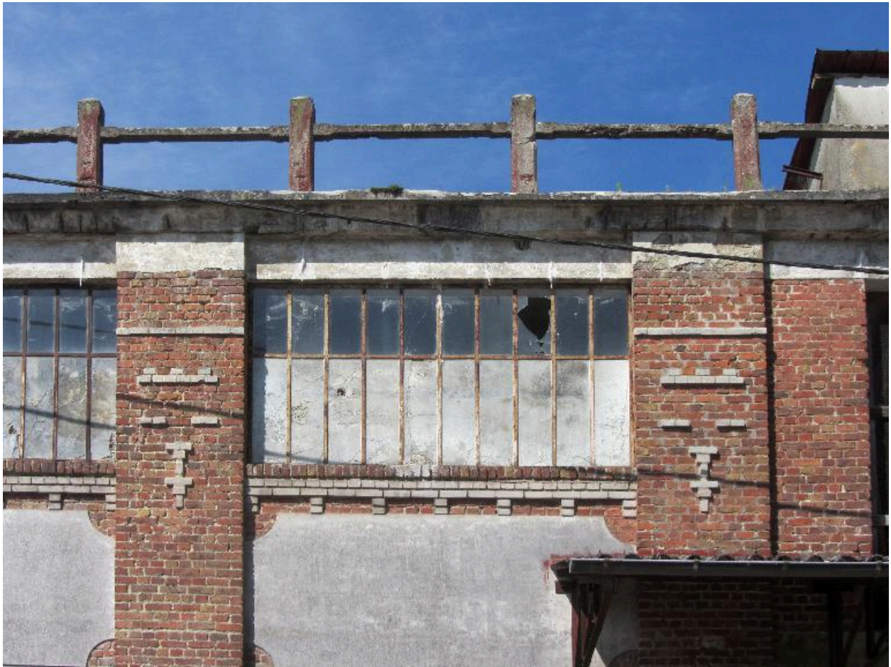
Détail des éléments décoratifs de la façade sur rue.
