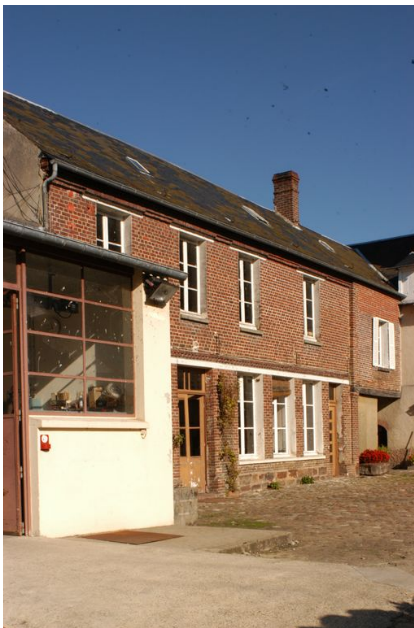
Les bureaux construits vers 1920.
