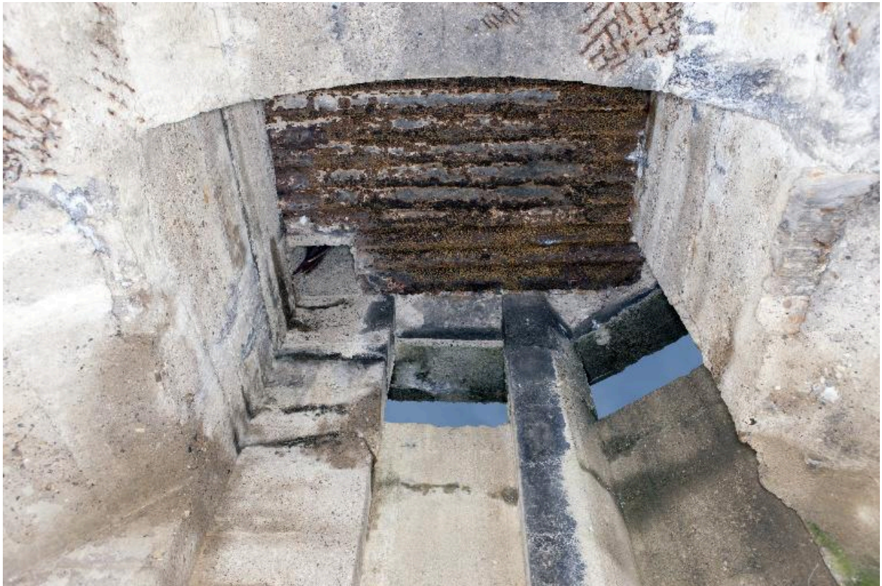
Le poste d'observation, en contre-plongée
