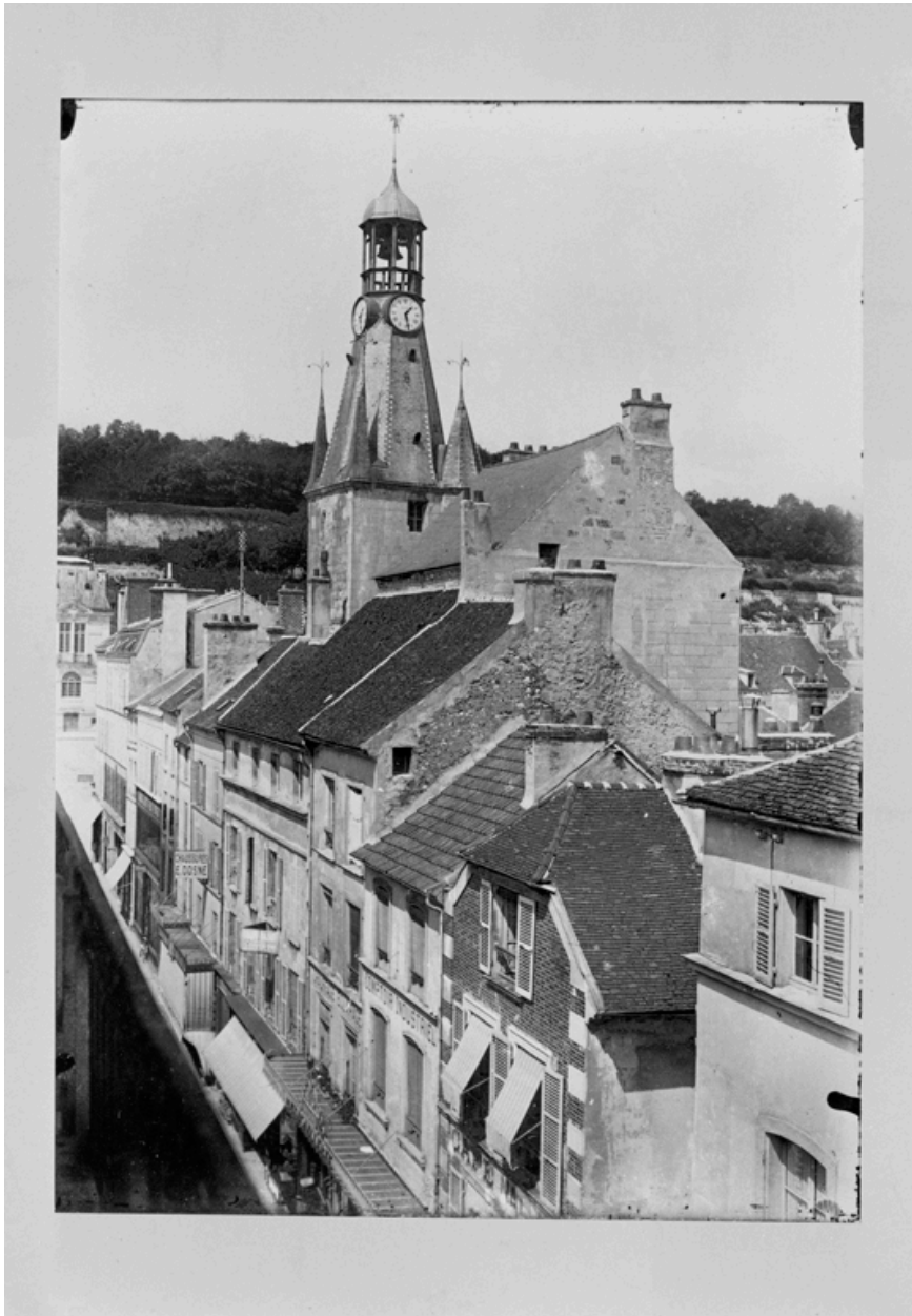
Vue générale depuis la rue ; cliché Richez, vers 1900.
