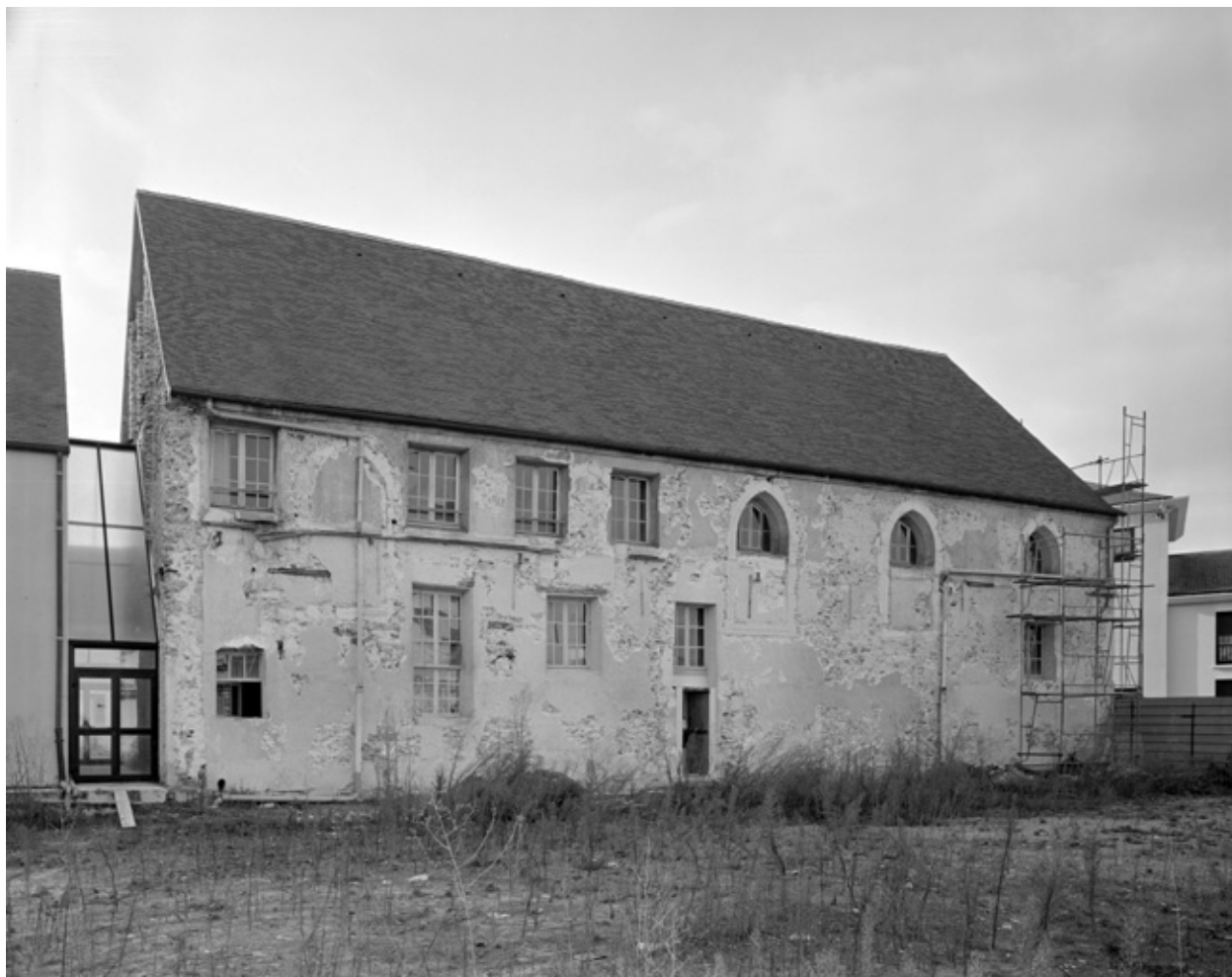
La face orientale de l'ancienne chapelle, en cours de travaux.
