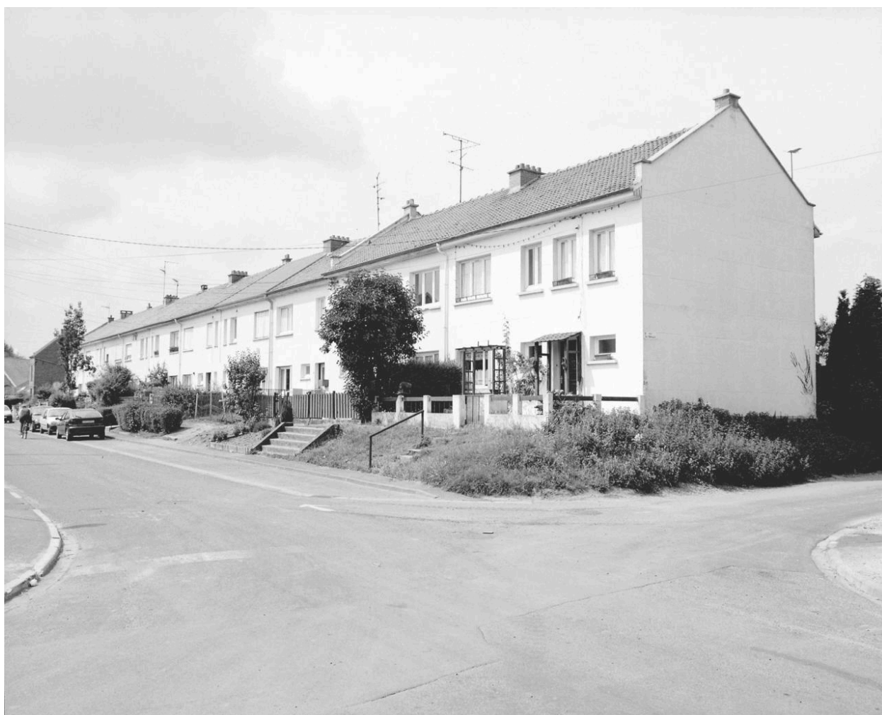
Alignement de maisons rue de la Puissance à Bachant.
