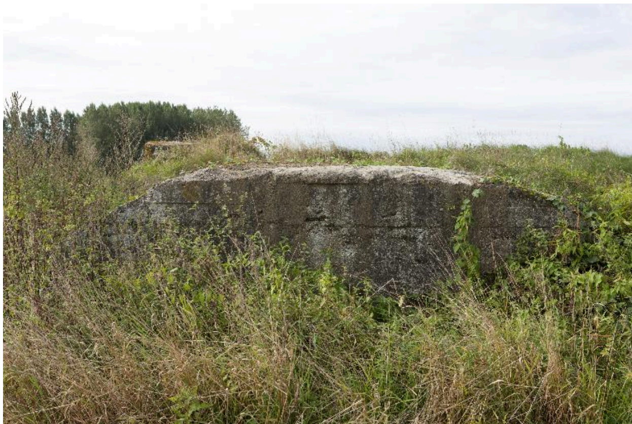
Vue latérale, vers sud-ouest
