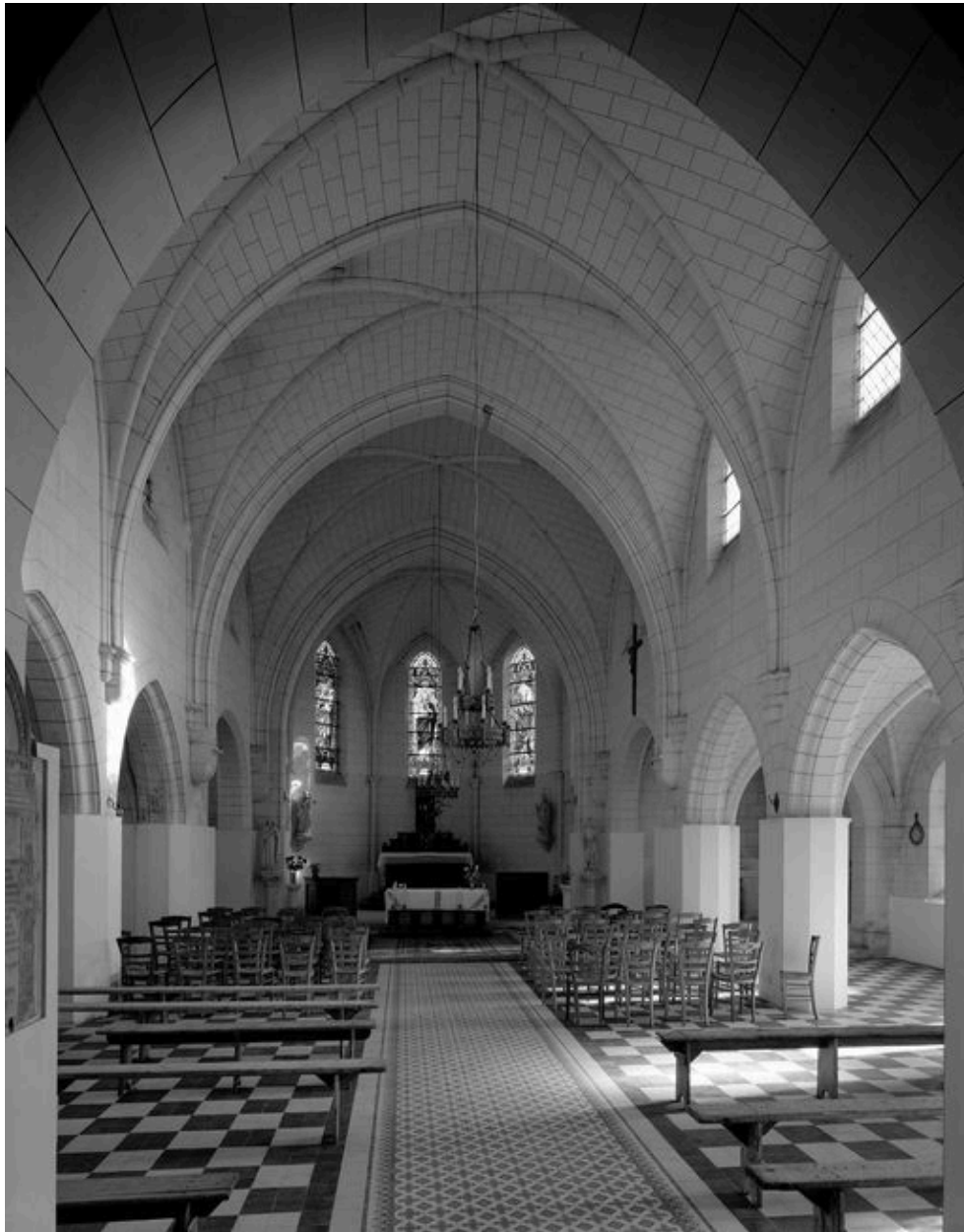
Vue intérieure vers le chœur.
